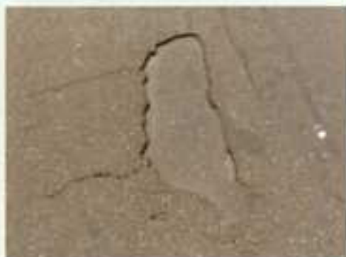
②YKパックス施工完了(即時交通開放)
