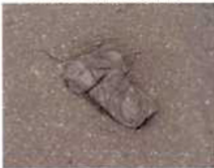
④YKパック施工完了(即時交通開放)
