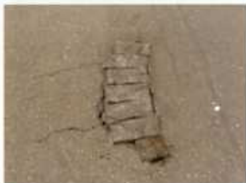
②YKパックス施工完了(即時交通開放)
