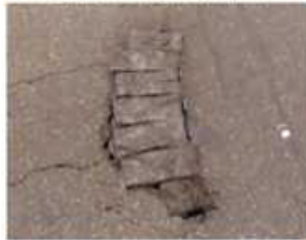
④YKパック施工完了(即時交通開放)
