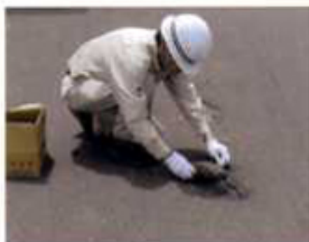
④YKパック施工完了(即時交通開放)
