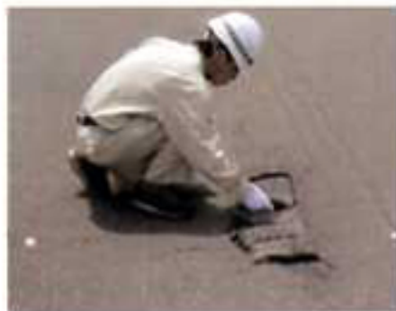
④YKパック施工完了(即時交通開放)
